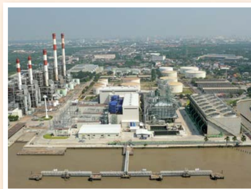
โครงการโรงไฟฟ้าพระนครใต้ ชุดที่ 3
